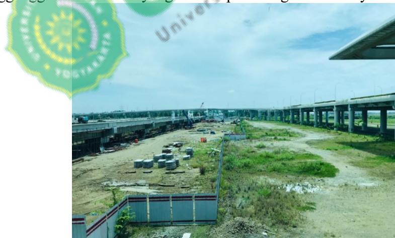
Gambar.2.3 Foto Kondisi Eksisting di ambil dari lantai 2 pada area 4 Sumber : Dokumentasi Survei Penulis, 2021
